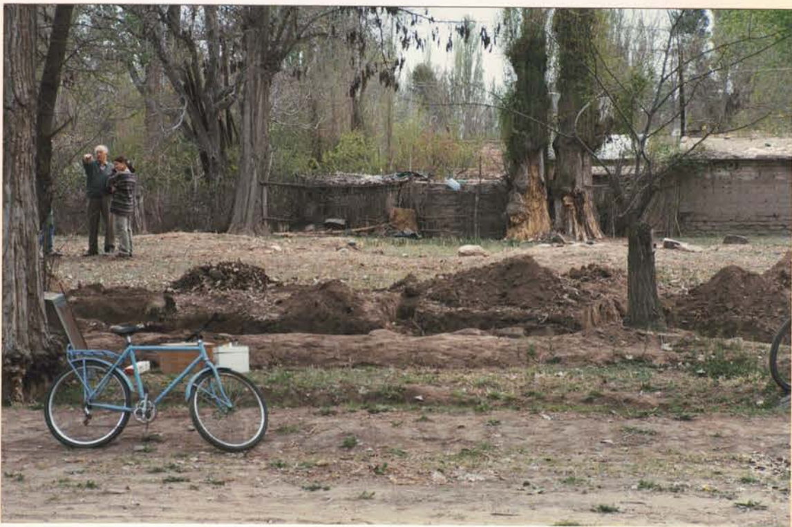
FOTO 10. Otra vista de los mismos trabajos en el sitio.
